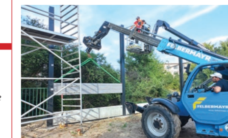
Instalácia protihlukovej steny za ZŠ Odborárska
