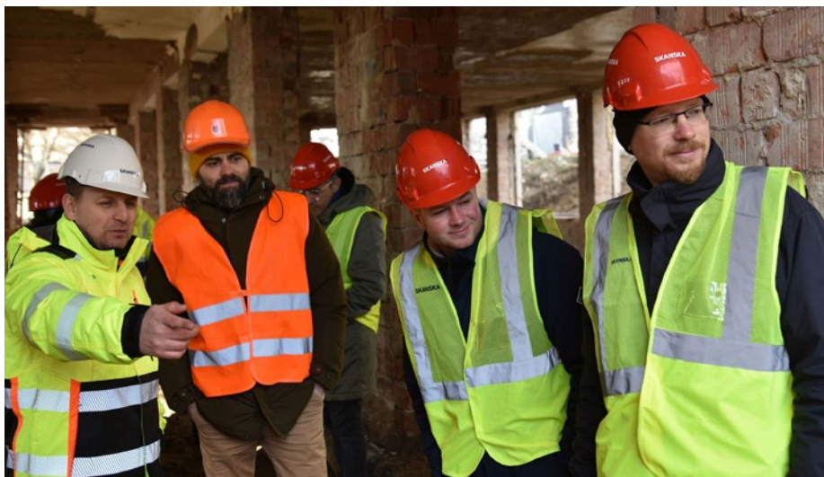
Kontrolný deň na ZŠ Cádrova. V rámci rekonštrukcie realizujeme nadstavbu, dostavbu a prístavbu pavilónu jedálne, čím sa výrazne zvýši kapacita školy.
